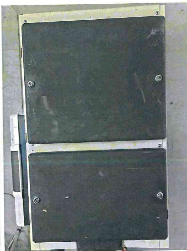
Rysunek 7 Kłapy wymiennika
